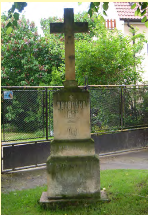
stav před opravou
