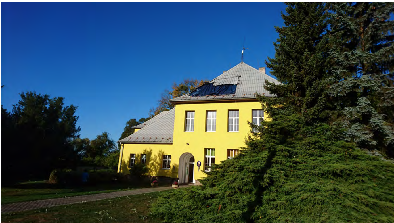
mateřská školka bez části střechy .....
